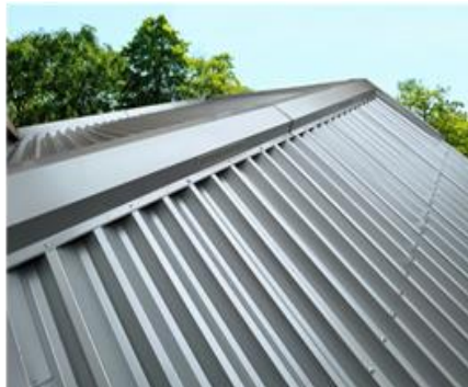
<屋根遮熱工事>
